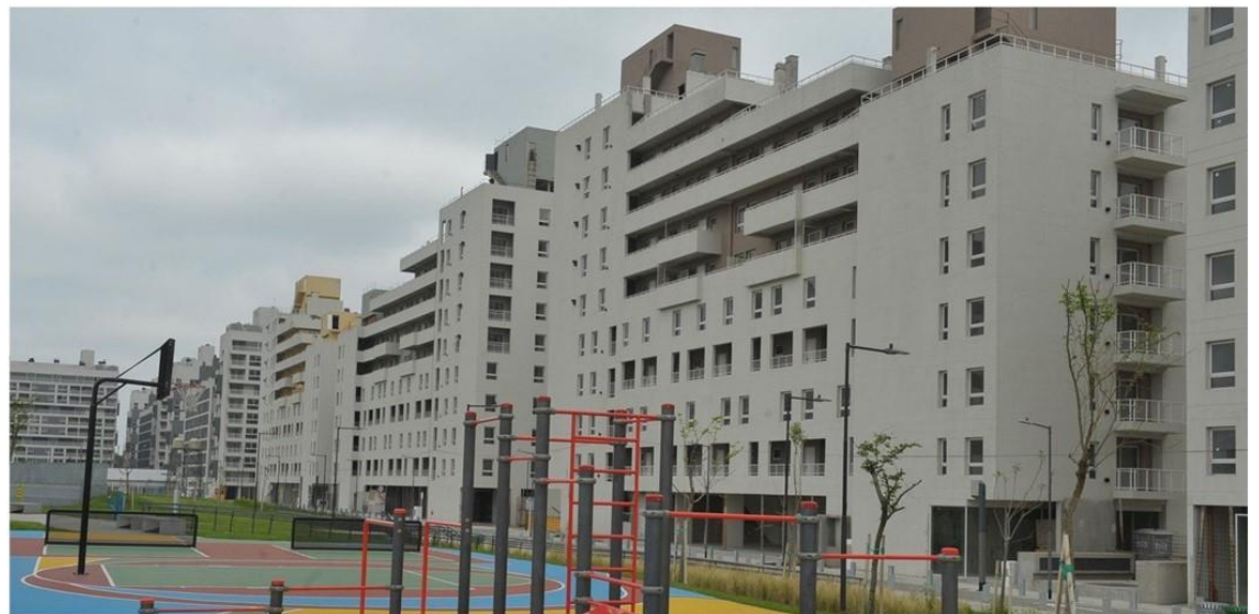
Vista parcial del Complejo Estacion Buenos Aires
